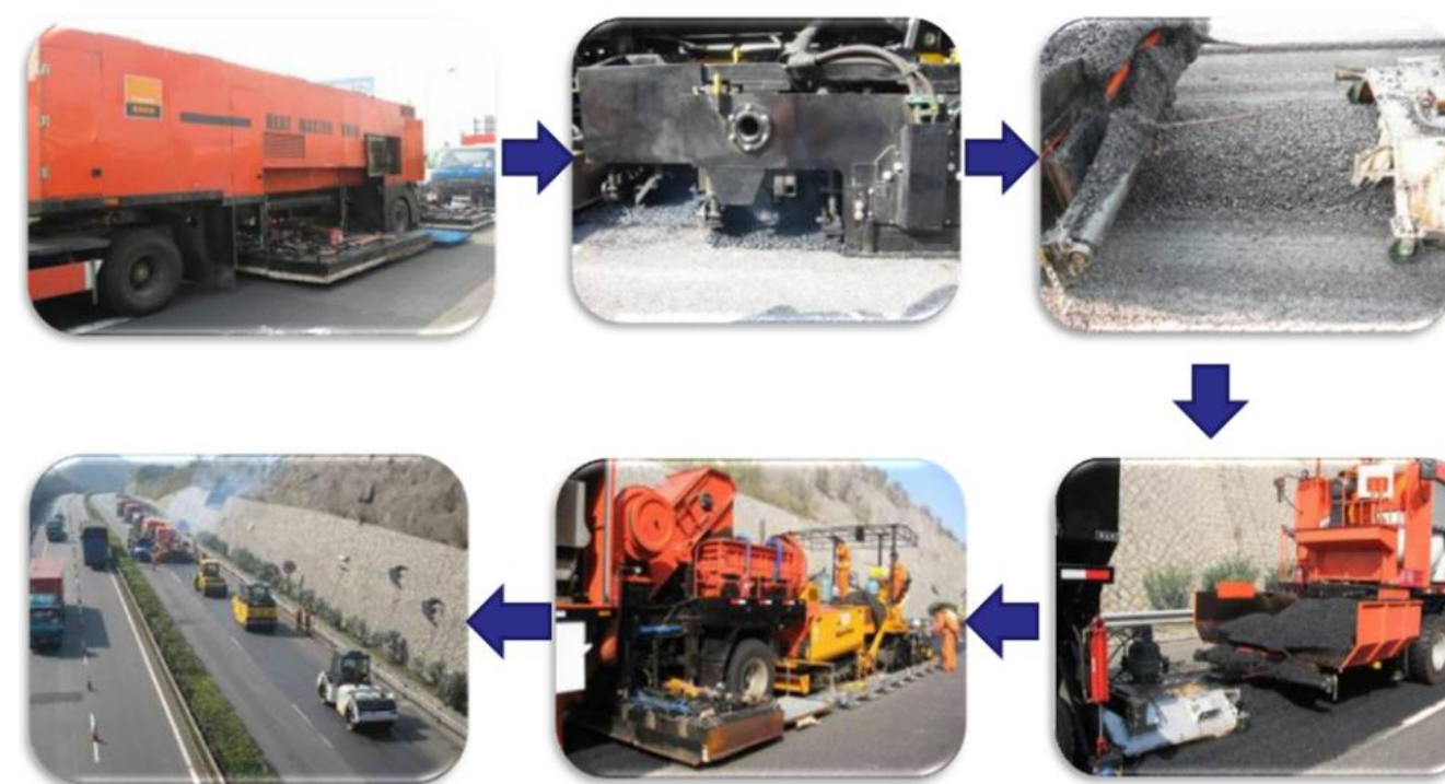
复拌再生各施工工序实景图
